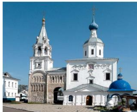
Лестничная башня, переход из дворца Андрея Боголюбского в церковь Рождества Божией Матери. XII–XIII вв.
